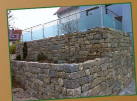
Gabionen und Mauern
